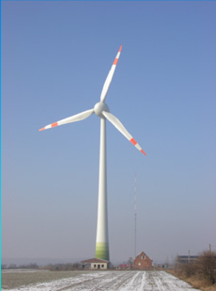
Enercon 4.5MW 112 meter rotor
